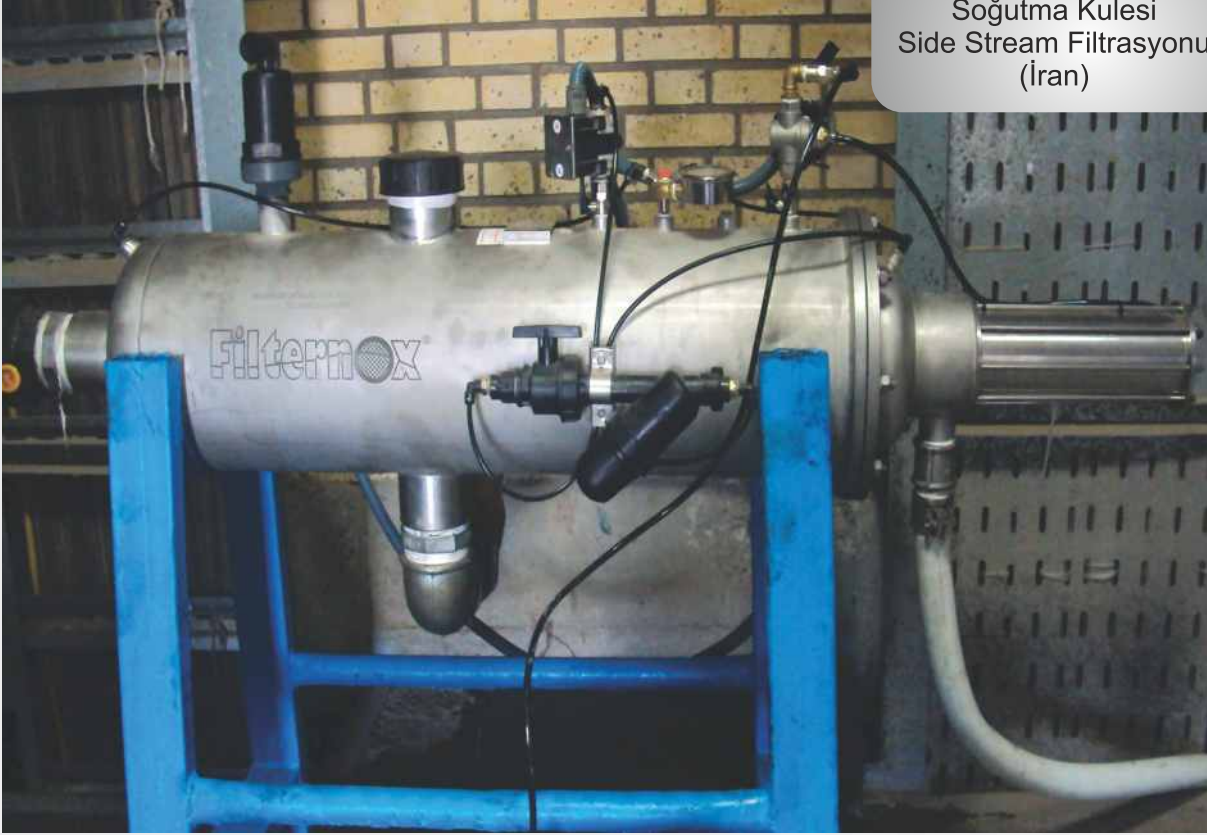
Soğutma Suyu Filtrasyonu (İran)
