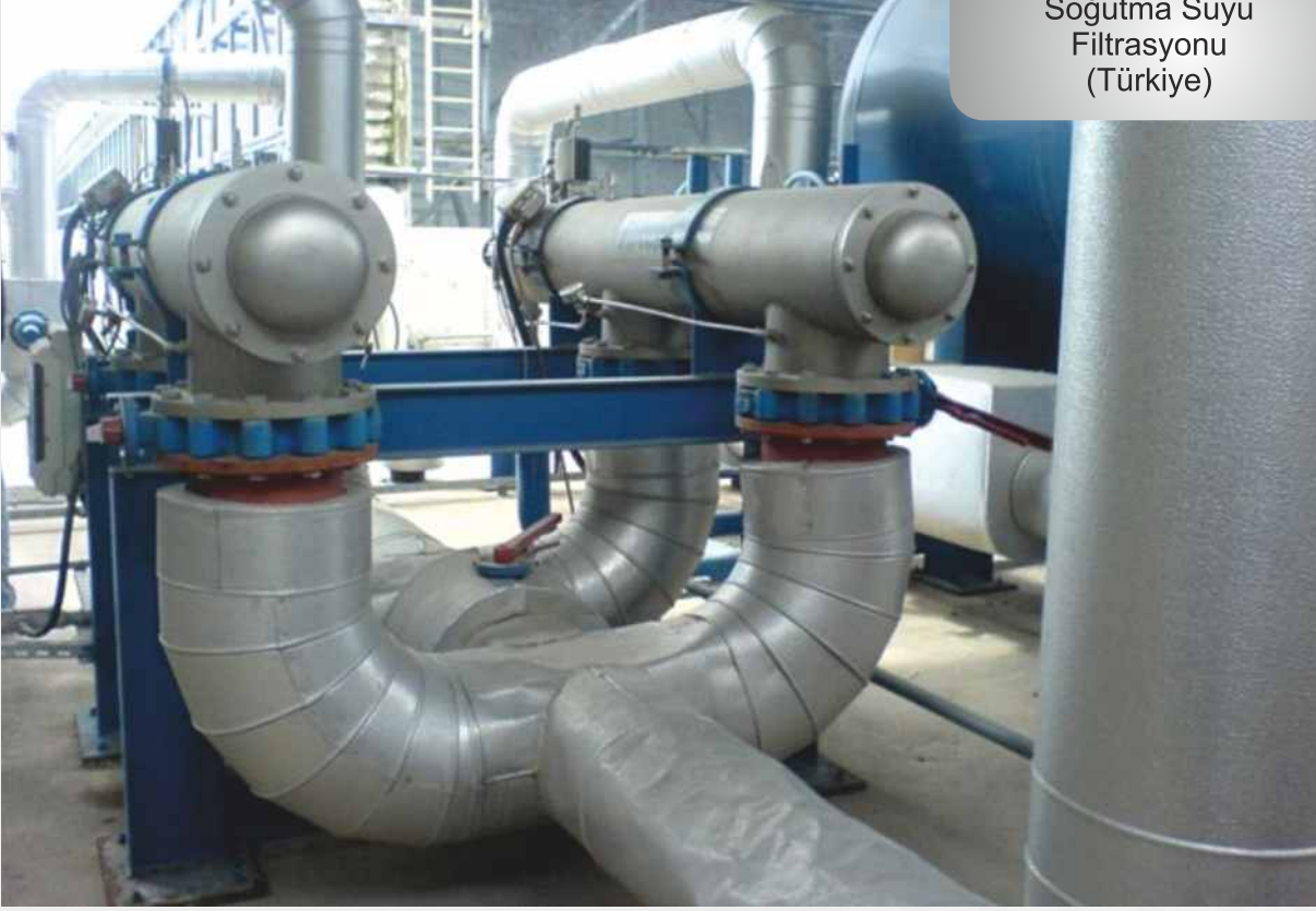
Cam Endüstrisi Soğutma Suyu Filtrasyonu (Türkiye)
