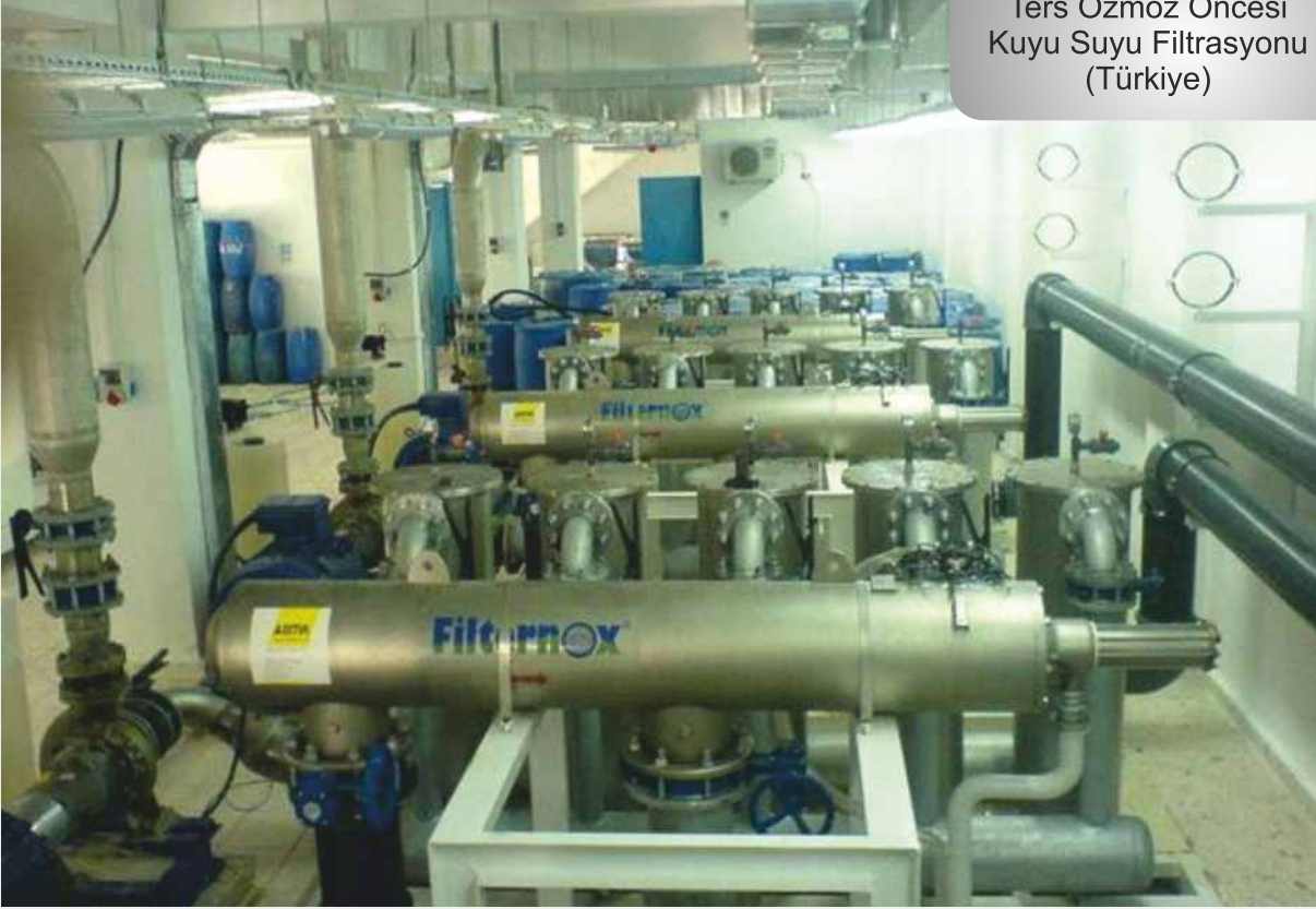
Yumuşatma Öncesi Kum Filtrelerinin Yerine Filternox® Otomatik Geri Yıkamalı Filtre (Türkiye)
