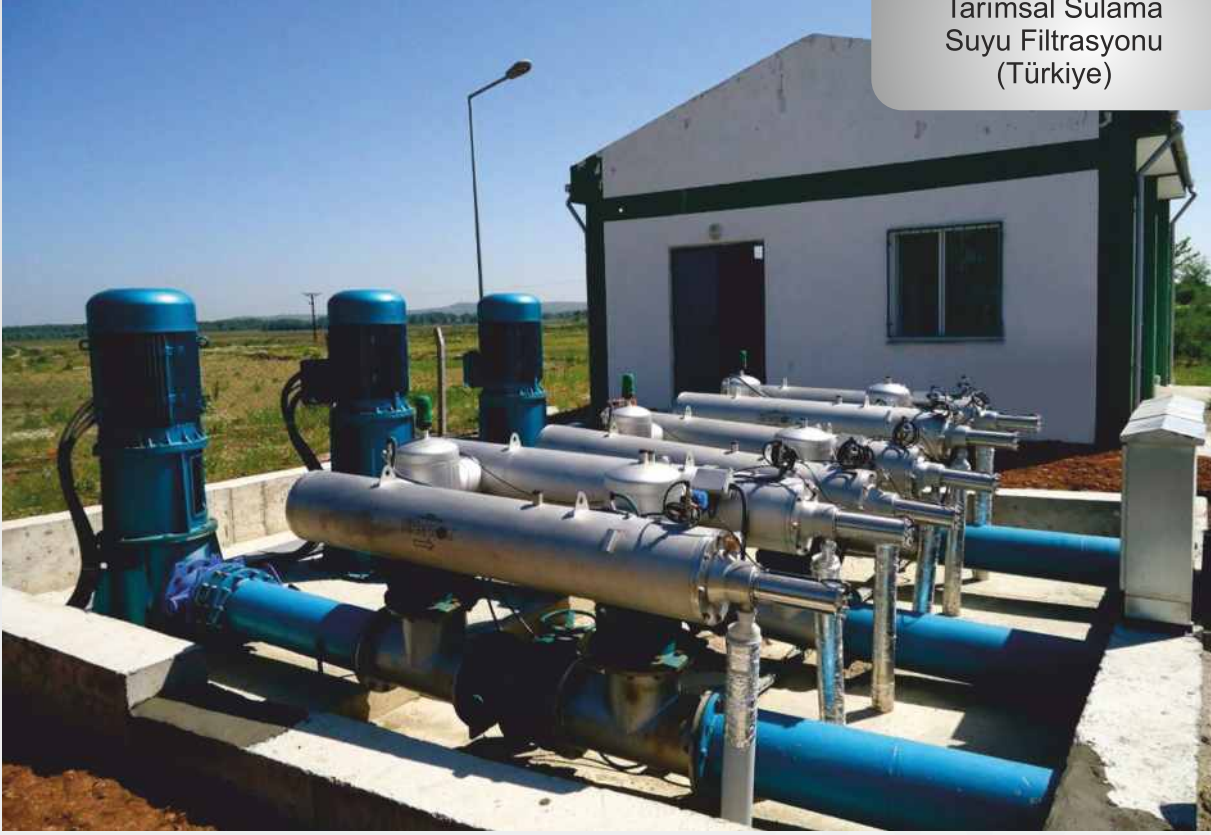
Tarımsal Sulama Suyu Filtrasyonu (Kazakistan)
