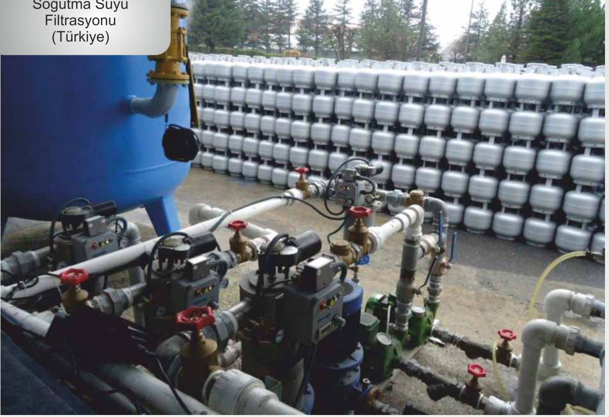
Plastik Endüstrisi Soğutma Suyu Filtrasyonu (Türkiye)
